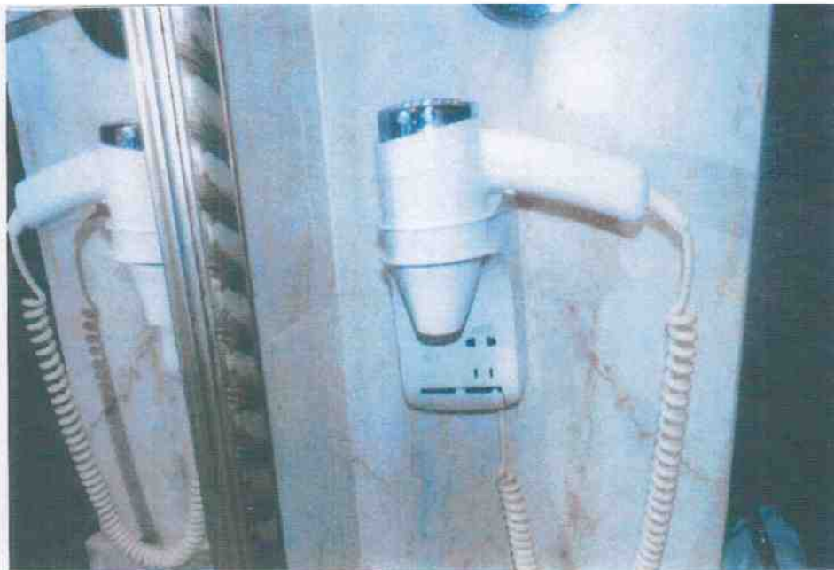
Obr. 34 Detail fénu v umývacím prostoru koupelny, patrná je i zásuvka pro napájení holicího strojku integrovaná v tělese fénu, zdroj [13]
