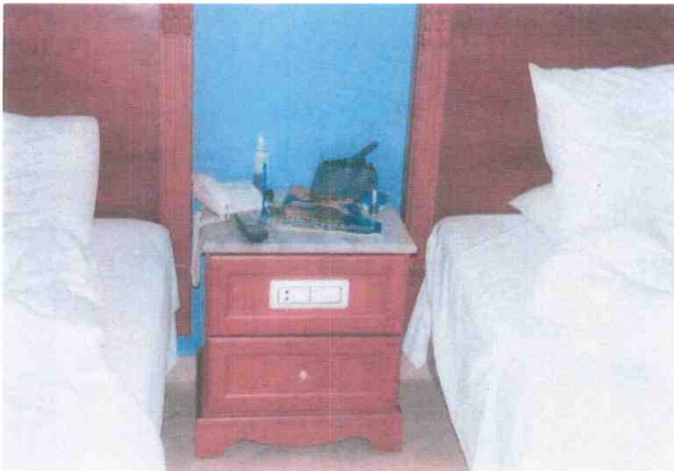
Obr. 22 Detail č. 2 nočního stolku s integrovanými spínači světél a zásuvkou pokoje 6343, zdroj [13]
