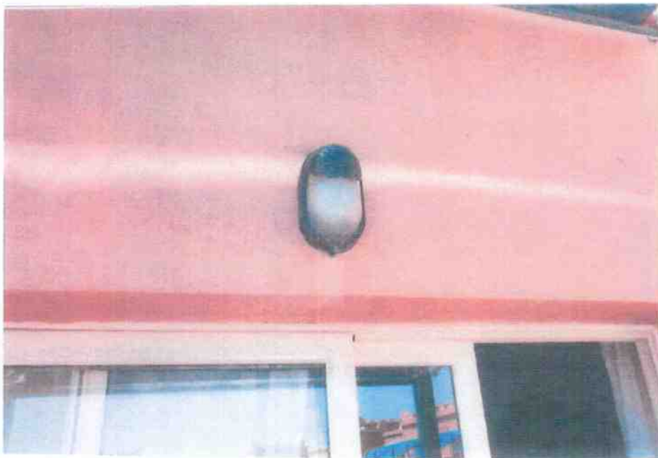
Obr. 31 Detail světla na balkóně, třída ochrany svítidla není identifikovatelná, zdroj [13]
